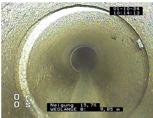
Verschobene Rohrverbindung
