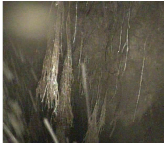
Komplexes Wurzelwerk
