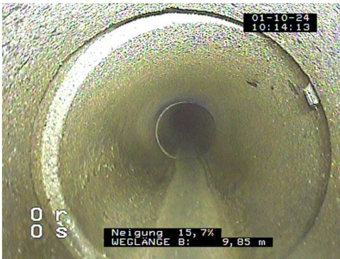
Verschobene Rohrverbindung
