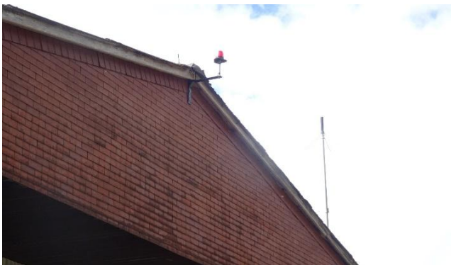
Abbildung 2-16: Antenne auf dem Dach des Betriebsgebäudes, Bächtold & Moor AG, 16.04.2024
