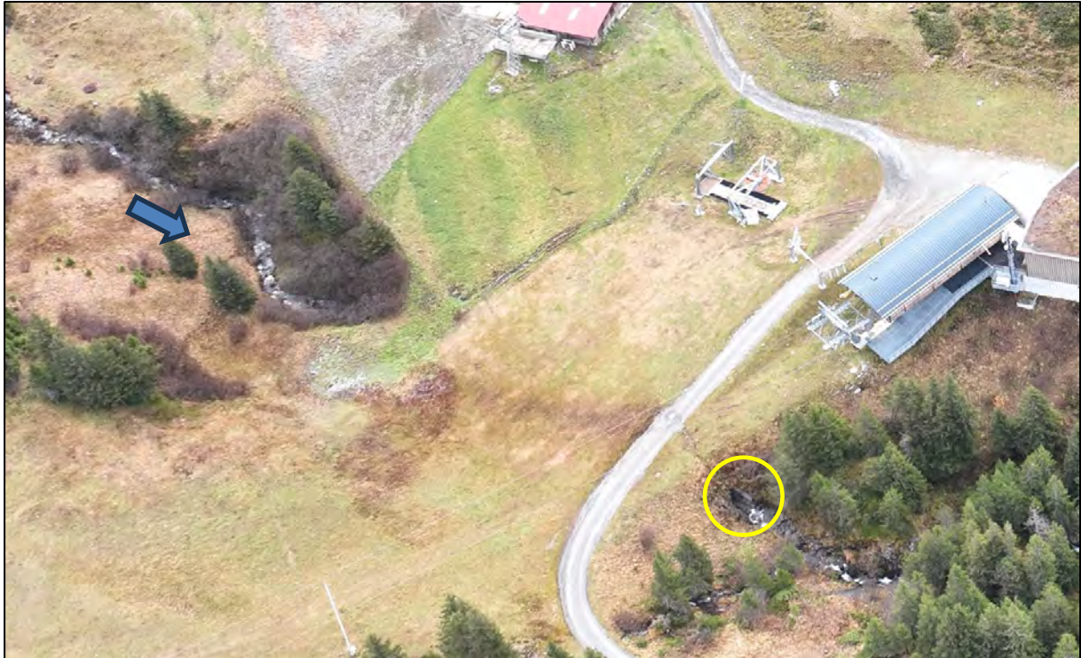
Abbildung 12: Luftbild des Bereichs «Wixi» mit dem Bachdurchlass (gelber Kreis). Der blaue Pfeil zeigt die Fliessrichtung des Nesselbachs.
