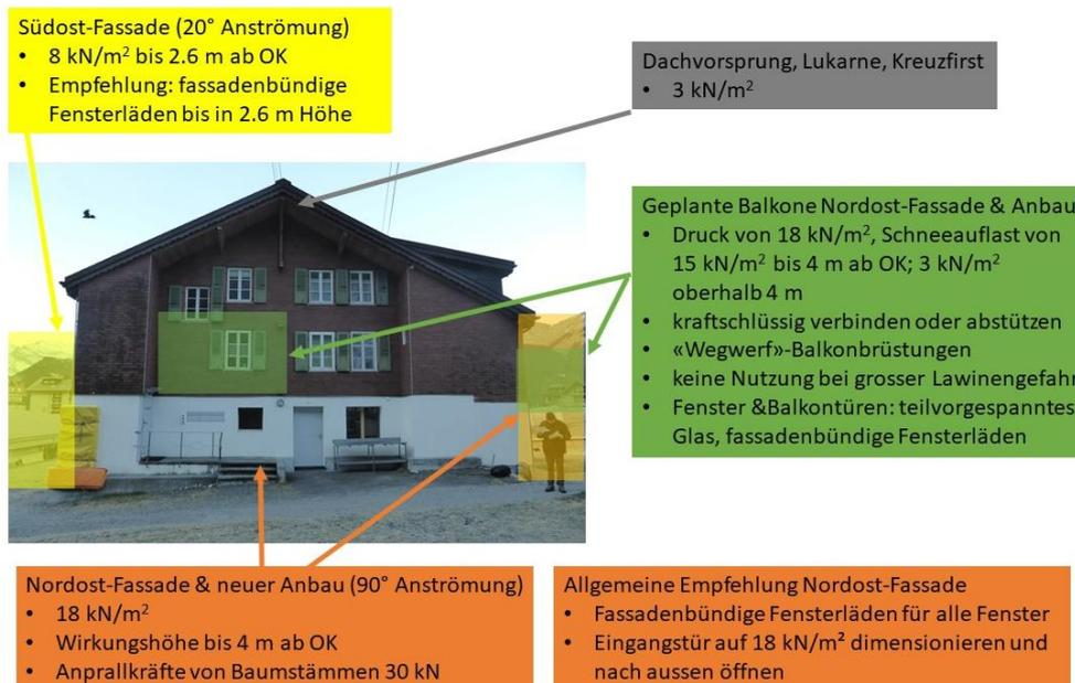
Abbildung 11: Skizze der Anströmungsrichtungen von Lawinen sowie der vorgeschlagenen Objektschutzmassnahmen Lawinen. OK = Terrainoberkante
