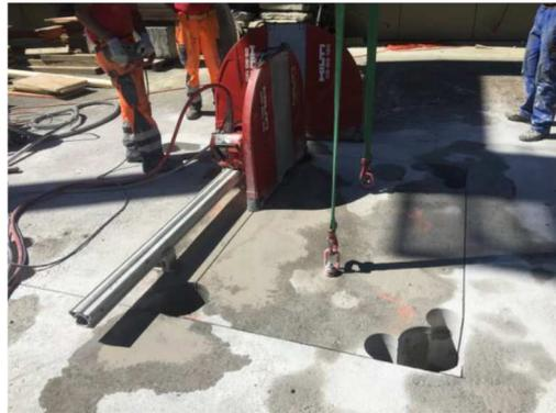
Fräsarbeiten durch die vorgespannte Betondecke
