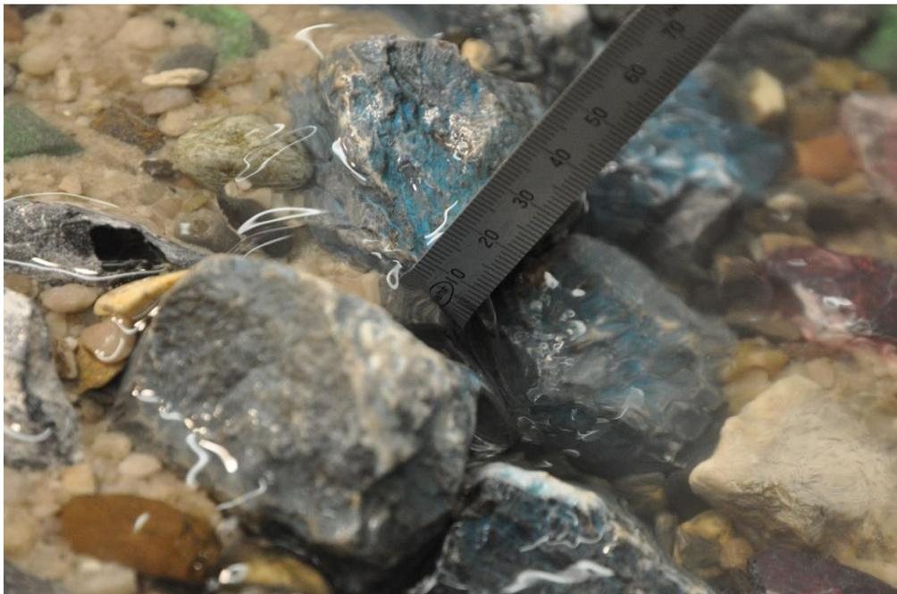
**Abb. 8** Für die Messungen ausgewählte Lücke in Querriegel Nr. 4. Die Fließgeschwindigkeiten waren sehr gering und optimal für den Fischeaufstieg.
