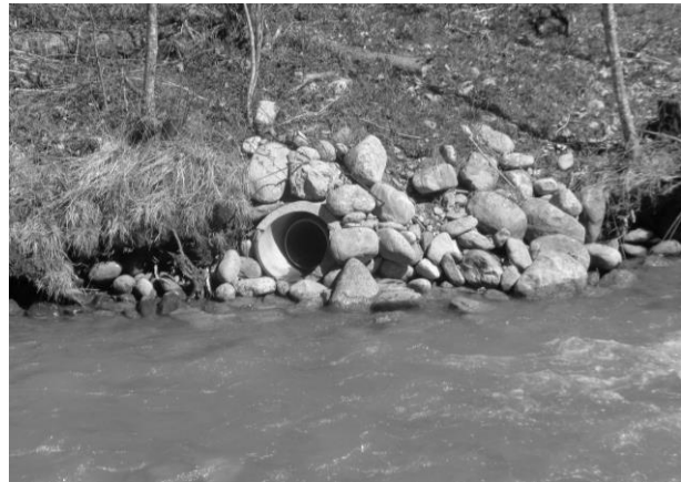
Einlauf in Lütschine
